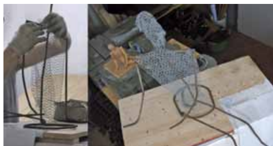
Applicazione delle rete metallica alla struttura in ferro
