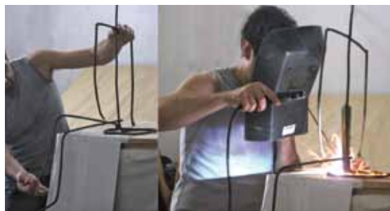
Preparazione e saldatura della struttura in ferro
